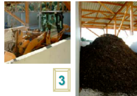
3 Chargement du mélange dans les couloirs de fermentation (4 semaines) puis maturation (4 semaines)
